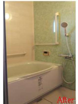
木津川市の兜台のマンションにお住いのT様のユニットバス工事です。35年ほど経過していて、そろそろ限界だと数社の相見積もりでした。最終的に当社をお選びいただき、併せてテレビドアホンの取替えの工事もすることになりました。工事はいつもの手順で解体後、メーカーの墨出しに従い、水道・電気の仕込み工事を行い、翌日ユニットバスの専門の職人さんが組み立てました。その後、水道・電気及び内装工事で予定通り無事終了しました。
