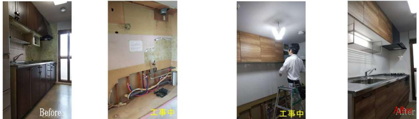
兜台のマンションにお住いのN様は前回、ユニットバスの取替え工事をご紹介したお客様です。今回は、システムキッチンの取替えと玄関のクッションフロアの張替え工事です。システムキッチンは、クリナップの「ラクエラ」という商品をお選びになり、4日間の工事を行いました。1日目は解体撤去及び設備配管の位置替え、2日目は吊戸棚下地及びクロス工事、3日目はキッチン組み立て工事、4日目に水道・ガスの接続工事などで無事に終了しました。
