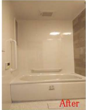
木津川市兜台のマンションにお住いのN様のユニットバスの取替え工事です。2月の初めにご連絡があり、システムキッチンの取替えや洋室の床フローリングへの張替えなどをご検討されておられました。何社かとの競合でしたが当社にお決めいただきました。ユニットバス工事は3月下旬で、初日に解体工事の上、メーカーの墨出しのうえ配管・配線工事を行いました。2日目にユニットバスの組み立て工事を行い、3日目に入り口木枠の取り付けなどの仕上げの工事です。洗面所の壁・天井のビニールクロスの張替えも完了しました。今、ユニットバス取替えのご希望が増えています。皆様、毎日お風呂に入ることで癒されたいのでしょうか。
