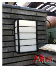
☆**外壁のクラックの補修**・・・外壁にクラックが入っていると光台にお住いのK様からご連絡がありました。現地確認をするとバルコニーの壁にまっすぐにクラックが入っており、防水の面で問題がある状態でした。そこで、クラックにシーリング材を充填したのち、現状の外壁の色と同じ塗装をしました。そのうえで、門灯のフレームが錆びていたため、防錆処置を行い塗装しました。大変喜んでいただきました。
