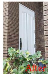
☆玄関戸の取替え・・・相楽台にお住いのN様のお家です。当初は、玄関戸の塗装のお考えでしたが、カバー工法による玄関戸の取替えと両方お見積もりをお出しして取替えをご判断されました。カバー工法は、現状の建具の枠を残して新しい枠をその上からかぶせていきます。そのため外壁に影響しないため1日で工事が完了できる優れた工法です。
