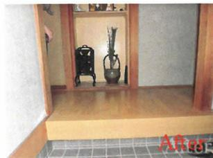
☆床の2重貼り・・・同じく中山町のI様からいろいろ修繕したいところがあるとお電話がありました。まずは浴室ドアの取替、浴室床タイルの張替、手すりの取付け、各ドアの取っ手の取替5か所、玄関ホールの床板の2重貼りなどで、2日間で順々に施工を行い、仕上がりはご満足いただきました。その間にも、建具のガラスの割れ、テーブルの設置及び、テラス屋根の貼替などのご注文をいただきました。
