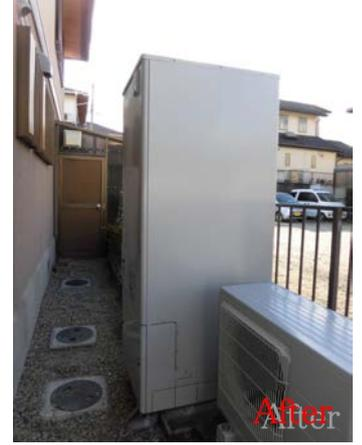
工事は、外部のエコキュート工事を水道屋さんの職人さんが2人で現状の機器の撤去工事後、新しいエコキュートの商品と同じ場所に設置して試運転後、お客様にリモコンなどの操作の説明をしました。浴室換気乾燥暖房機への取替え工事は、大工さんに天井部のカット及び補強工事後、電気屋さんが機器を取付、同じく試運転を行い完了しました。1日での工事でお客様から感謝のお言葉をいただきました。こちらもお礼を申し上げます。ありがとうございました。
