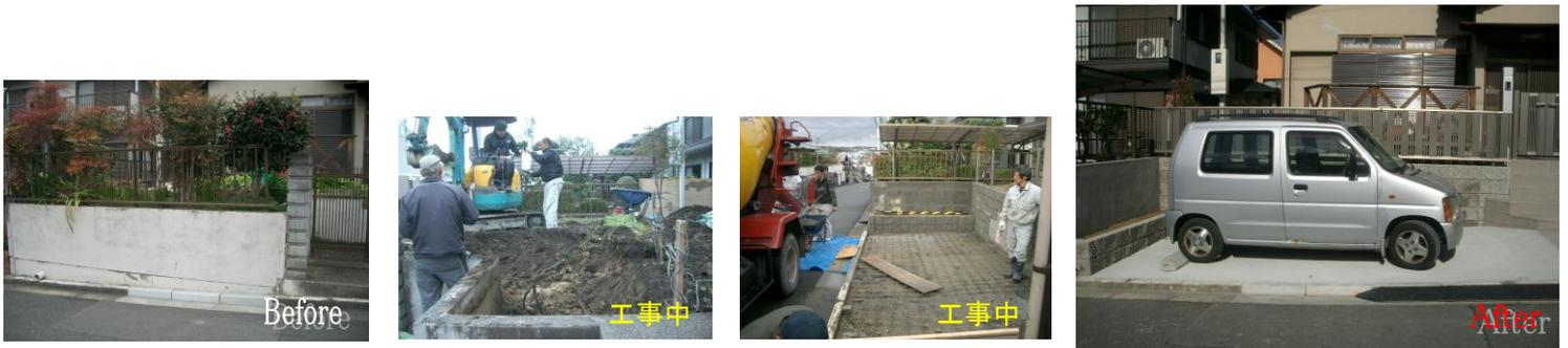
以前、システムキッチンの取替工事をさせていただいたK様の外回りの工事です。駐車スペースは1台分あるのですが2台目のスペース増設と門廻りの改修工事です。まず、道路に面した塀の内側の土を撤去し、区画を整形したうえで地盤を突き固めます。そのうえでメッシュ筋を配筋しコンクリートを打ち、左官で仕上げます。門廻りは新しい門扉・フェンスに取替、床はタイル張りで見違える空間になりました。
