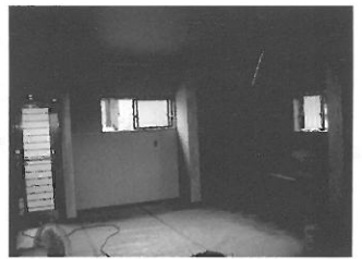
下地貼り完了
