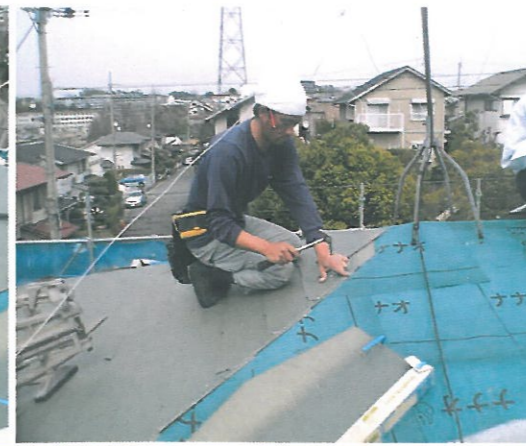
屋根カラーベストの葺き替え工事中
