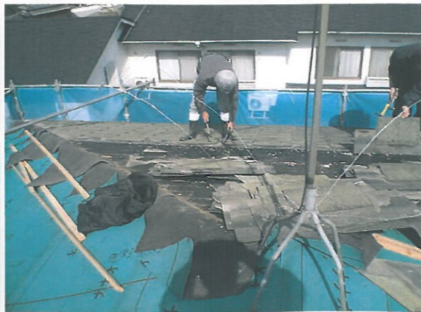
既存のカラーベストの撤去作業中
