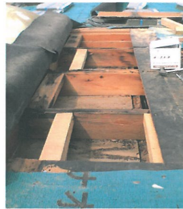
腐食した屋根下地材
