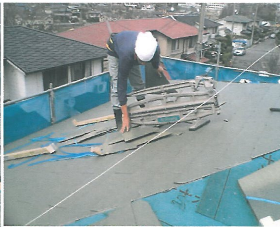
屋根カラーベストの葺き替え工事中
