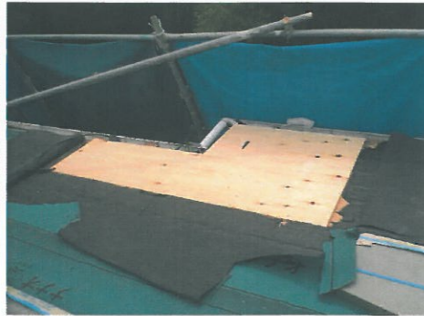
既存のカラーベストの撤去作業中
