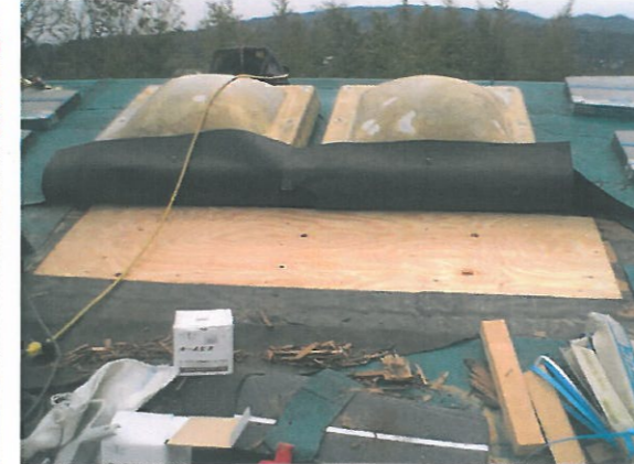
屋根カラーベストの葺き替え工事中
